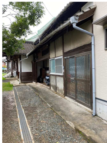
庫裡正面 (被災翌日)
