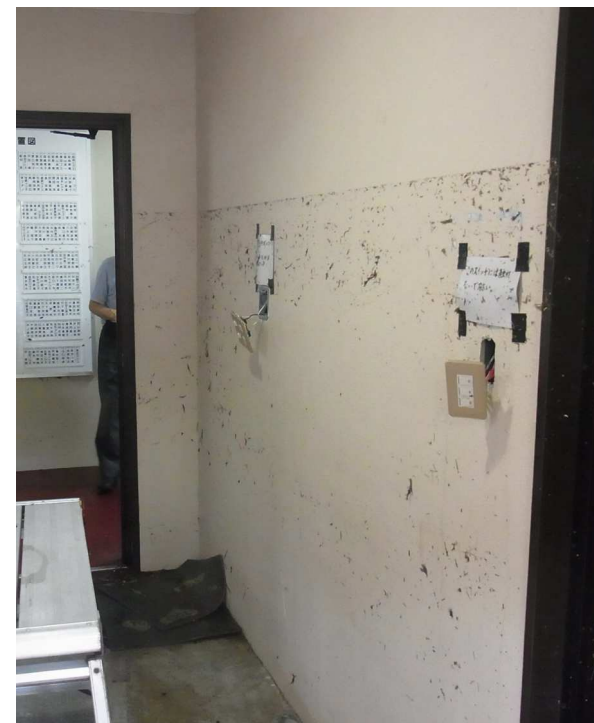
納骨堂入口（被災2日後）
