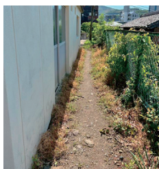
側道の伐根・ 落下防止用フェンス設置・ アスファルト舗装
